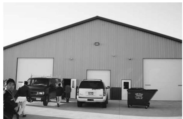
トラックを丸ごと洗車・消毒する施設の外観
