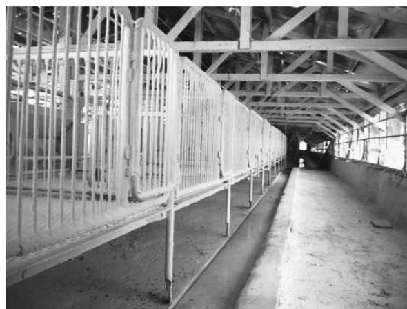
<ピット槽まで洗浄消毒>
