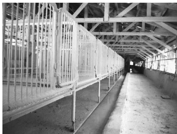
<ピット槽まで洗浄消毒>
