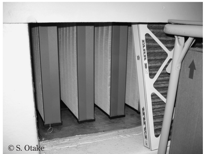
写真2 DOP95%空気フィルター（内側）
