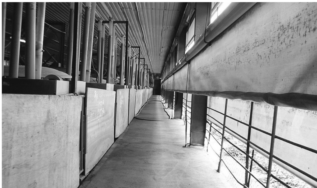
写真3 コンパネによる外気の豚房流入防止
