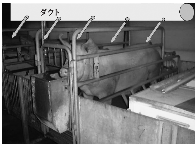
図1 ダクトの風向き うしろから首筋に当てる。風を嫌う豚はうしろに下がって避ければよいが、前からの風は逃げ場がないので不快
