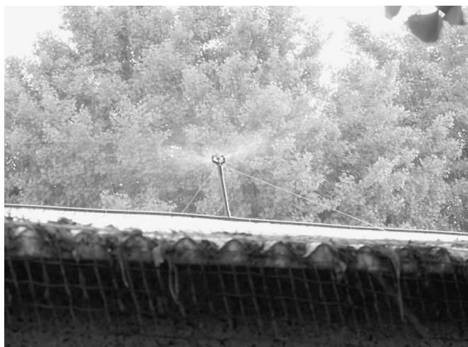
写真3 屋根の上にスプリンクラーを設置して散水
